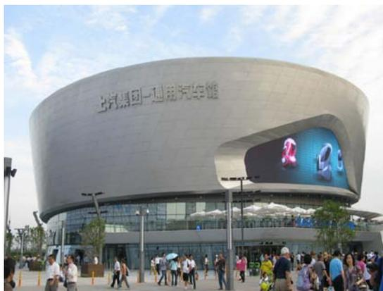
在场馆建设方面，上汽通用汽车馆是世博园区内第一家奠基的场馆，虽然所选取的“旋动”设计方案十分复杂，但为了能将“升腾汇聚”的建筑理念早日呈现在世人面前，建设团队严格项目管理，经常加班加点、通宵作战，并采用了锥面螺旋铝板加工和定型、幕墙骨架精确测量定位、50分贝影剧院无门槛隔声防火门、超宽
